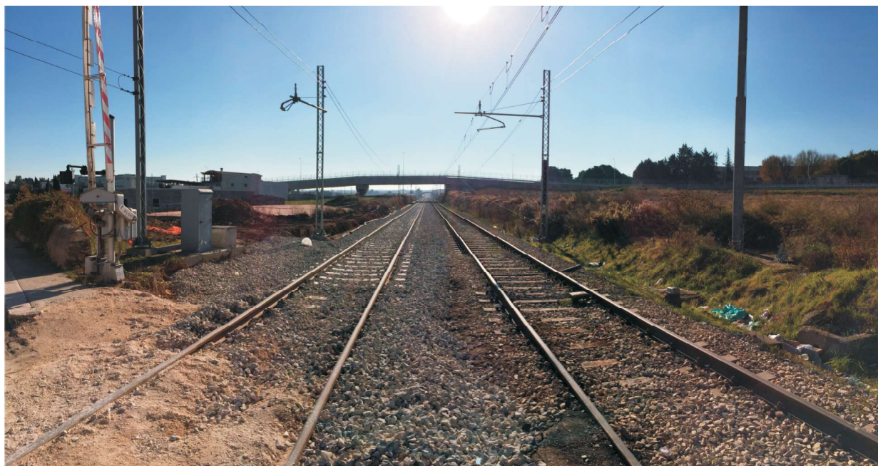
Stato dell'arte dei lavori in corso nell'ambito del progetto di riqualificazione della linea ferroviaria in comune di Corato – costruzione del secondo binario in corrispondenza del passaggio livello all'altezza di via Ruvo
