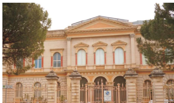
Ospedale Miulli, sede storica da riqualificare situata nel centro cittadino.
