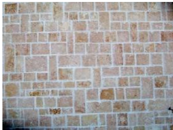
Muratura di pietra squadrata
