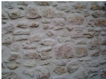
Muratura di pietra non squadrata
